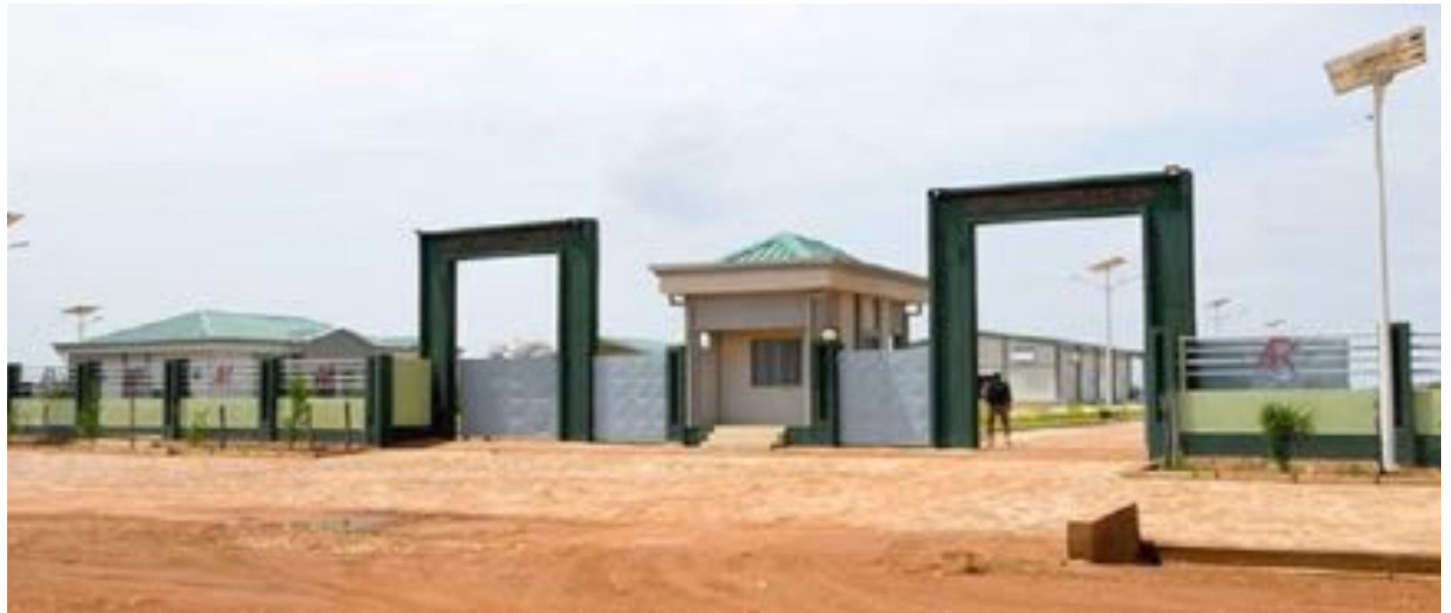
L'abattoir frigorifique moderne de Kaya, une infrastructure moderne dotée de toutes les commodités, pour contribuer à la transformation structurelle de l'économie burkinabè. (Ph. DR)
